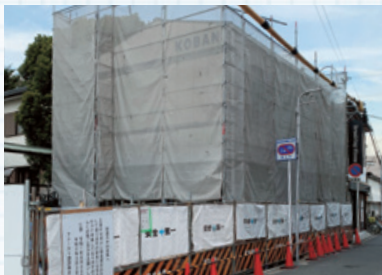
▲建て替え工事中の北助松駅前交番
