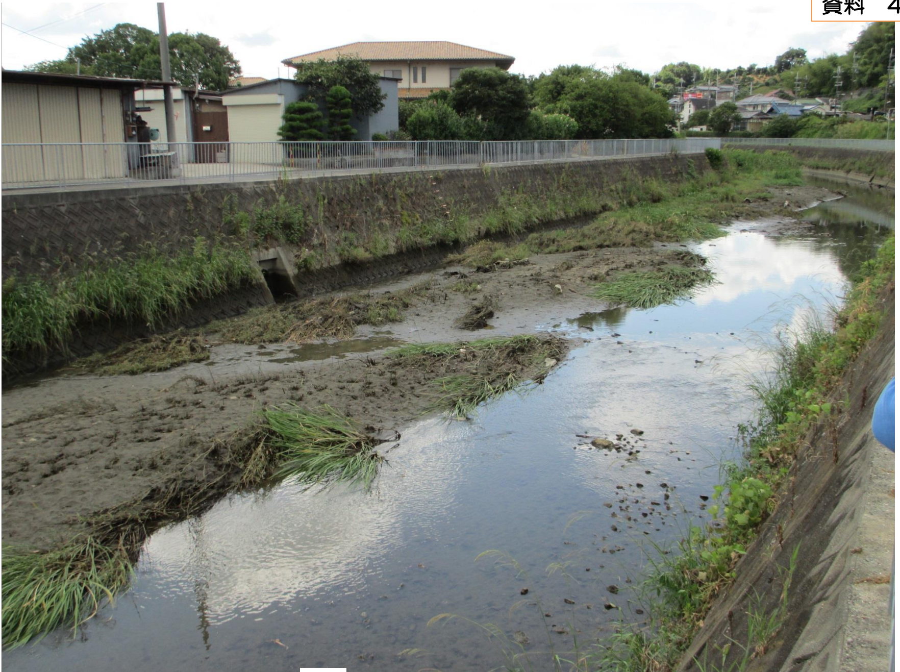
④河川内の状況
