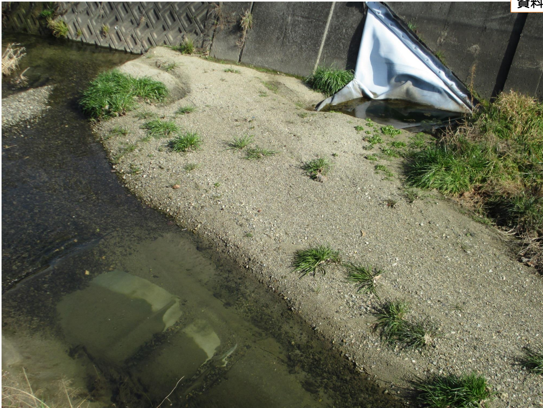
⑤土に埋もれるゴム堰
