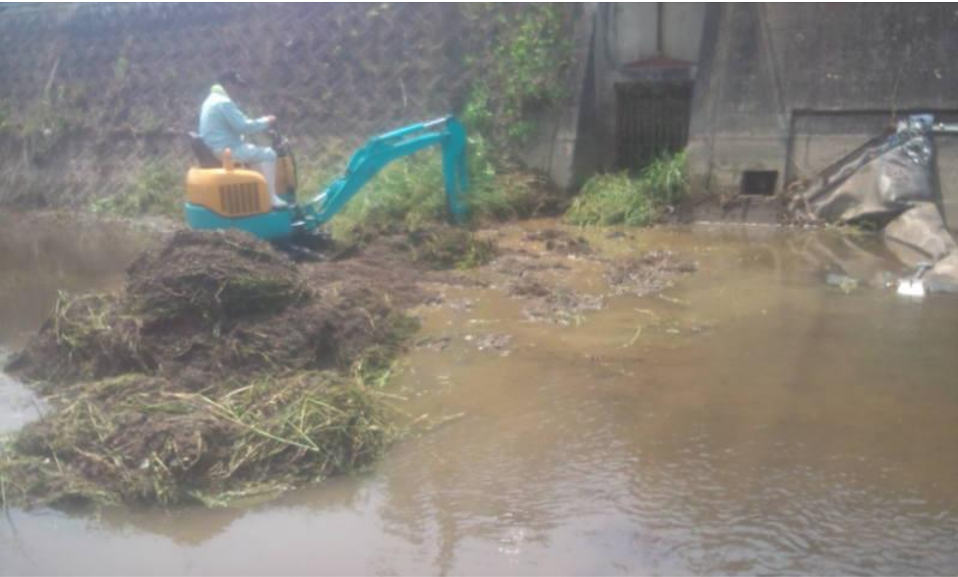
⑥取水口の土砂撤去作業
